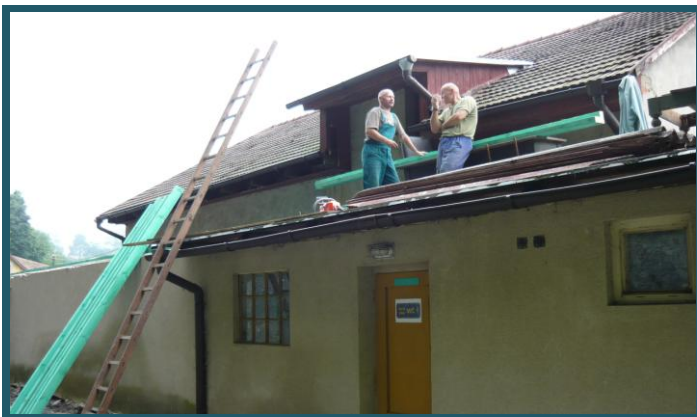
Tělocvična během orovádění oprav
