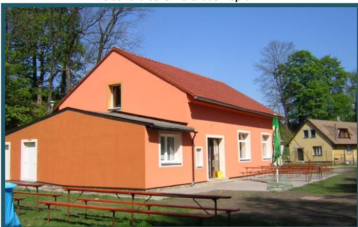
Stav tělocvičny po opravách
